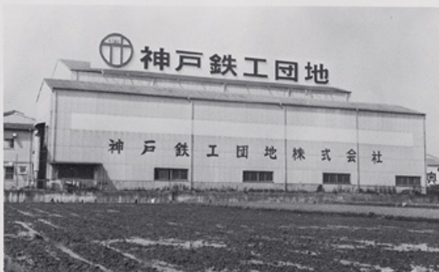
▲ 共同作業場全景
