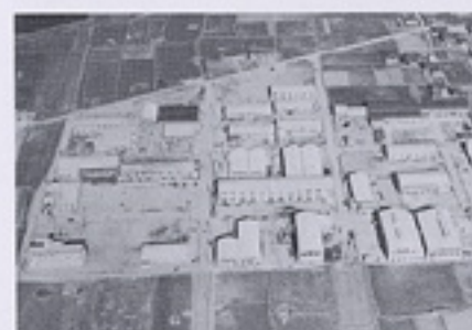
▲神戸鉄工団地誕生当時の全景
