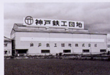
▲共同作業場全景
