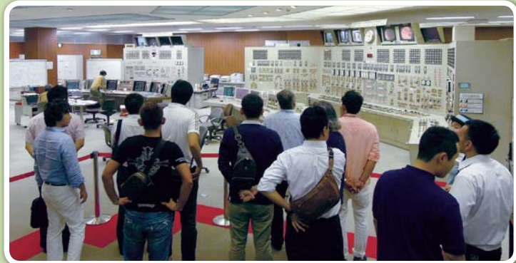
平成25年9月 研修旅行(中部電力碧南火力発電所)
