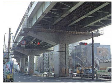
団地内の工場で作った高架橋脚補強材
