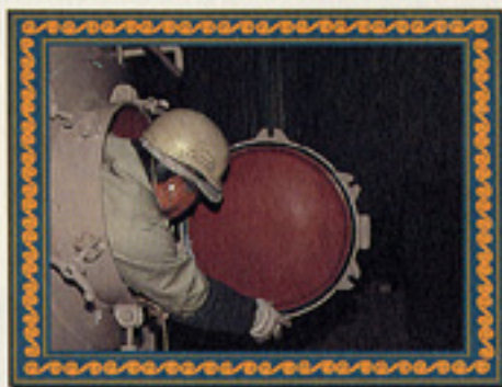
大型装置の組み立て
