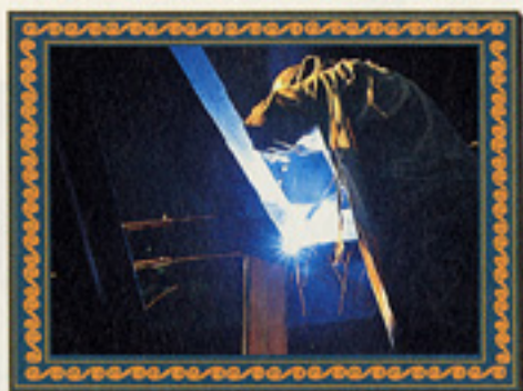
大型装置の溶接加工
