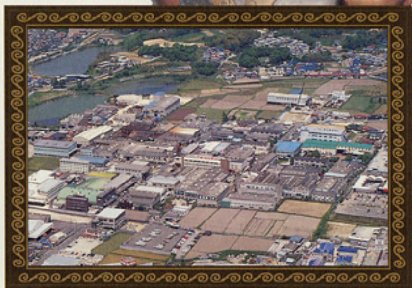
神戸鉄工団地の全景
