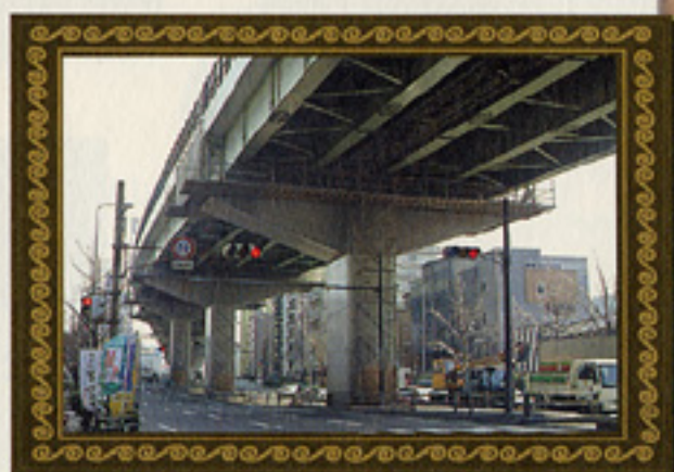
団地内の工場で作った 高架橋脚補強材
